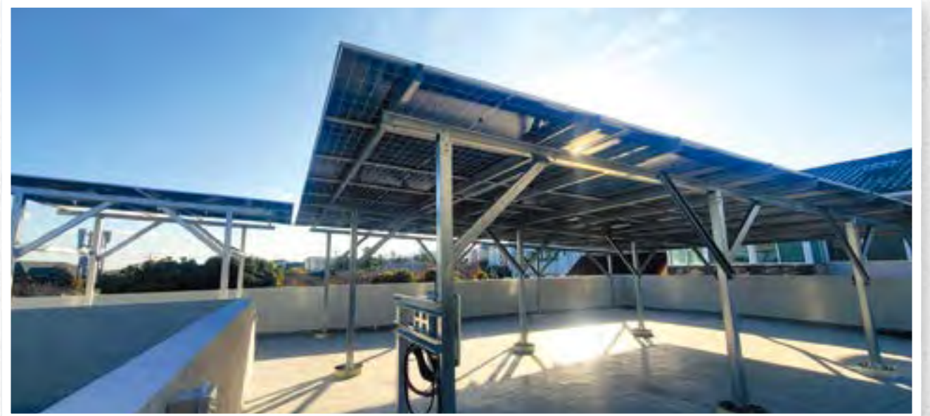
옥상 태양광시설 설치 (2025.12.04.)
