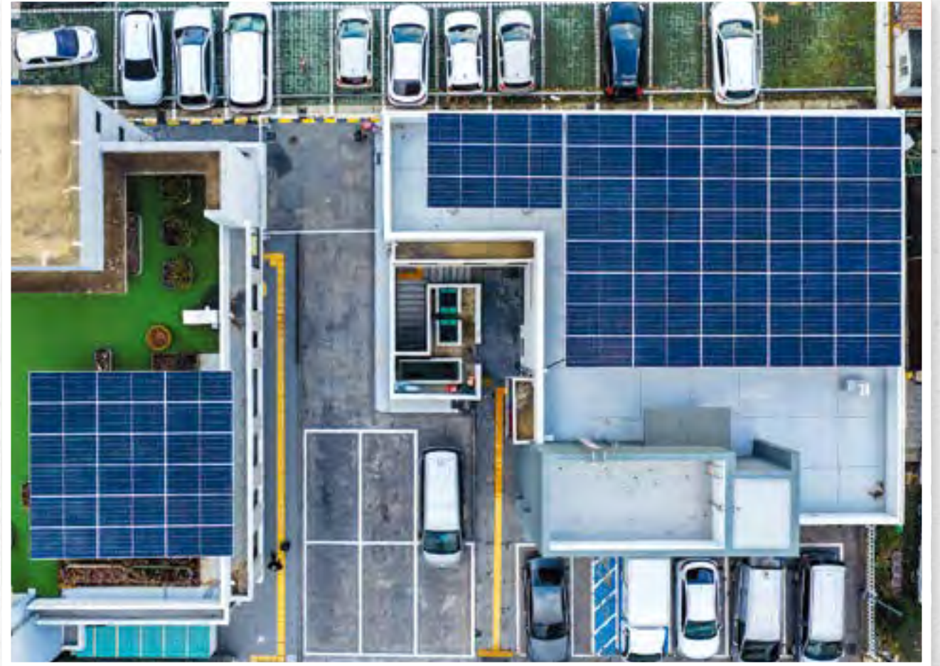
옥상 태양광시설 설치 (2025.12.04.)
