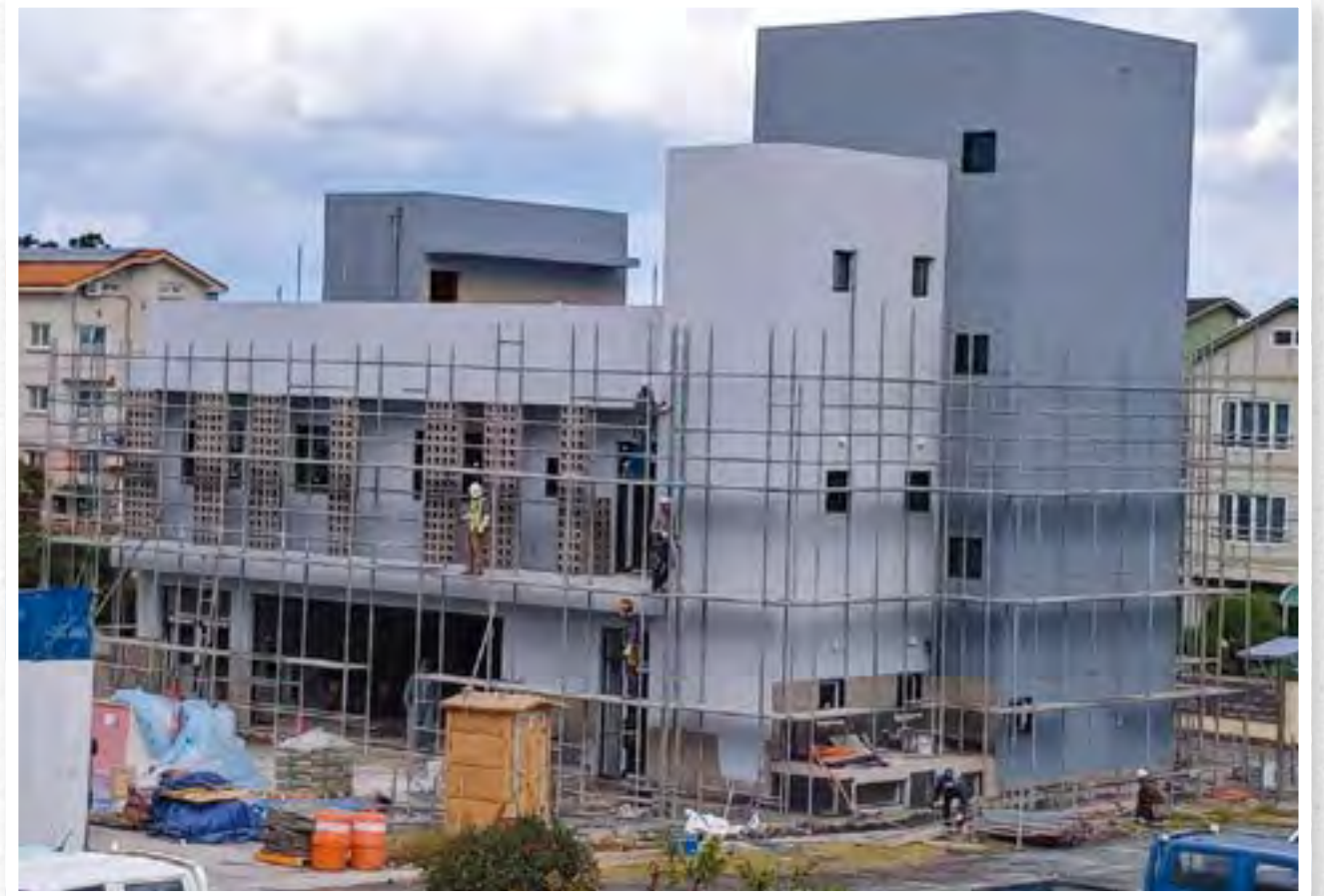
희망나래복합공간 공사 현장 (2021.11.09.)
