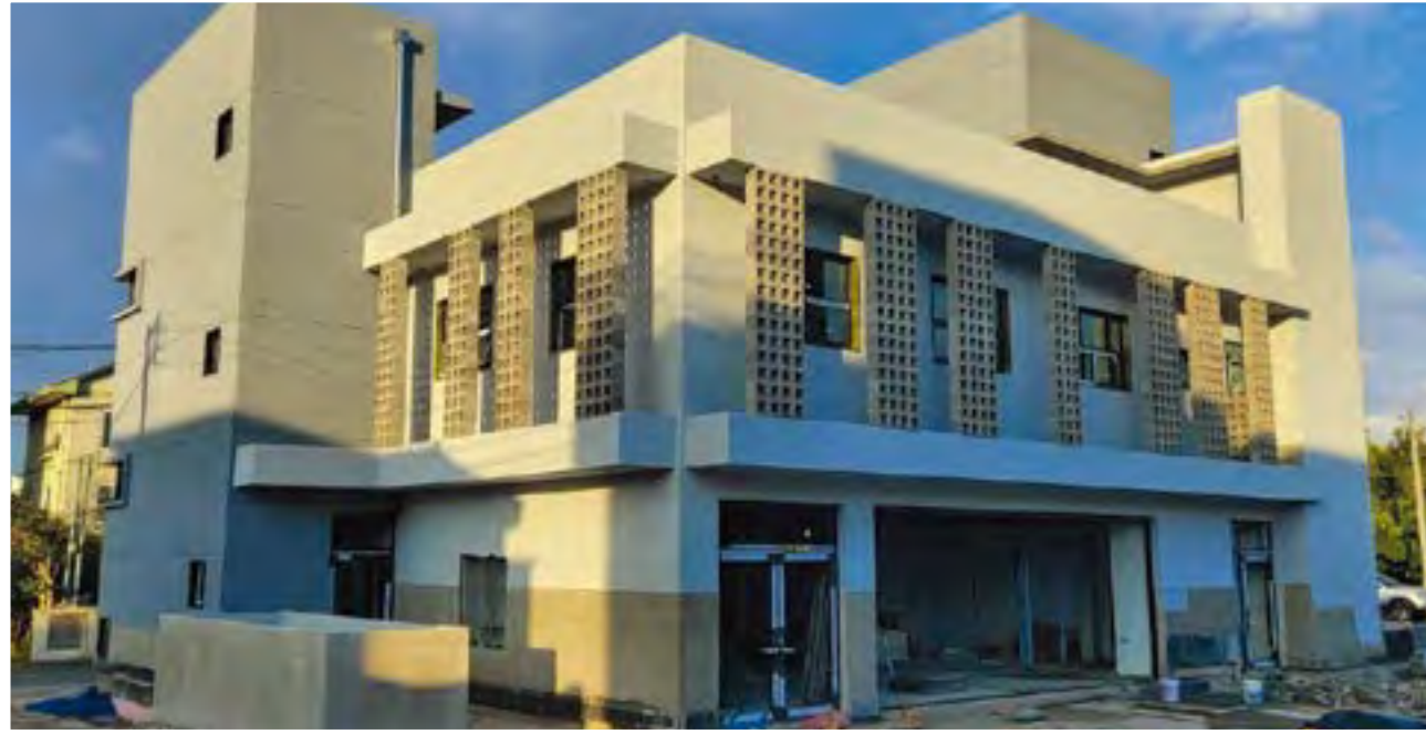
희망나래복합공간 공사 현장 (2021.11.12.)
