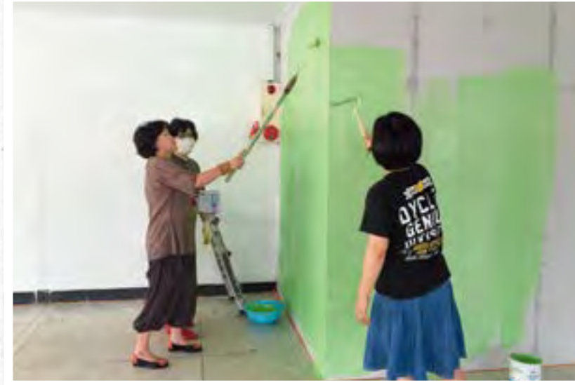
아산빌딩 사무실 이전 공사 (2016.08.15.)
