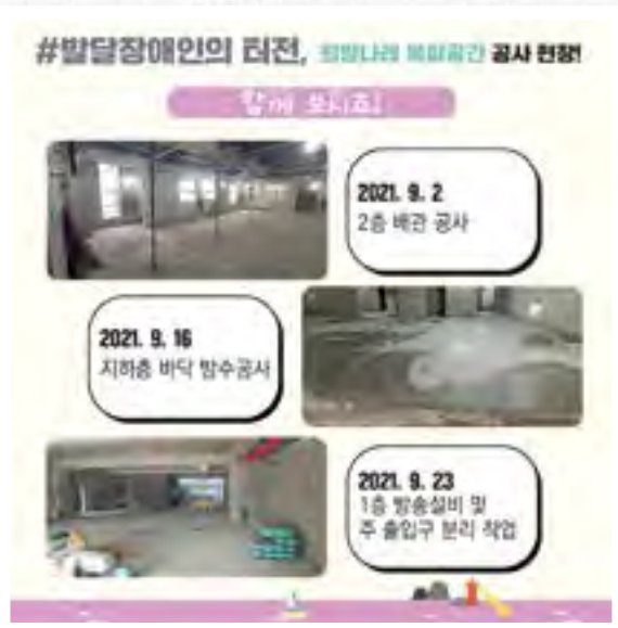
희망나래복합공간 공사 현장 (2021.10.07.)
