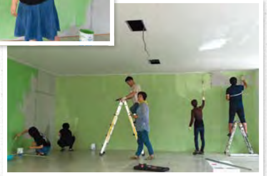
아산빌딩 사무실 이전 공사 (2016.08.15.)
